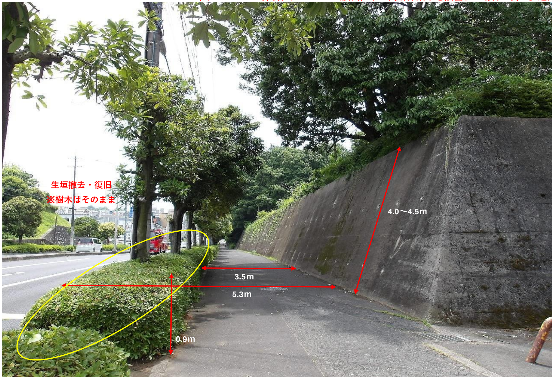
図 02-1-5 作業イメージ（法面直下に高所作業車を設置する場合の例・歩道）
